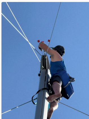
Maik in 23 Metern Höhe: der Verklicker ist repariert.
